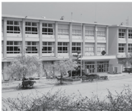
【水野小学校校舎】
