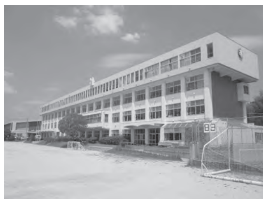
【運動場から見た日進東中学校の校舎】
