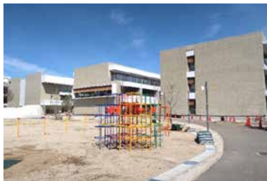
【完成した新校舎】
