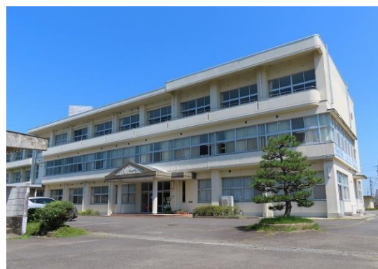
【奥田小学校の校舎】
