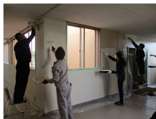
【壁面塗装の様子】
